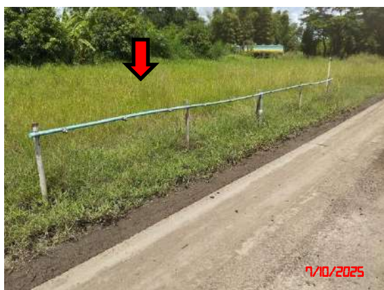
รูปที่ 20 ระบบสเปรย์น้ำล้างล้อรถบรรทุก
